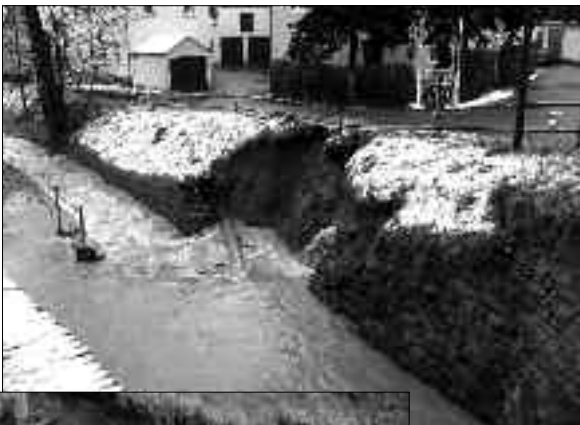
Hohe Straße OT Ottendorf Schäden an Bachmauer durch Unwetter 12.04.2008
