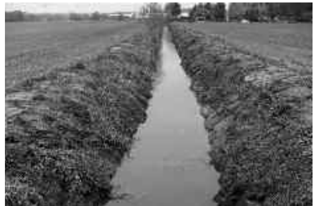
Entschlammung Dorfbach Aue Niederlichtenau
