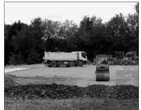
KP II Bau Sportplatz 1, Rathausstraße 3, OT Auerswalde
