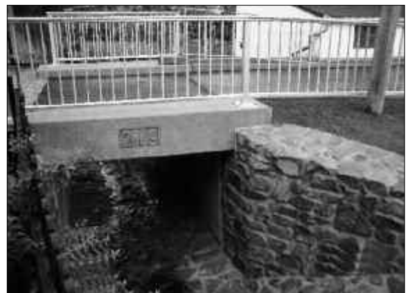
neue Brücke OT Auers- walde
