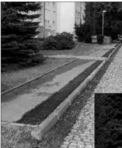
Reparatur Fußweg Rathausstraße
