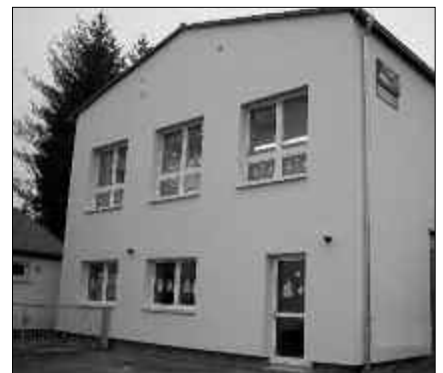
Hort Niederlichtenau KP II Maßnahme abgeschlossen
