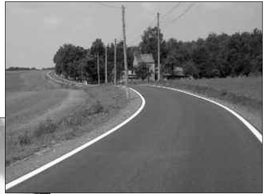
Ziegeleistraße fertig gestellt. Zwischen Merzdorf und Ottendorf wurde der 2. und 4. Bauabschnitt der Deckensanierung beendet. Für die Baumaßnahme erhielten wir Fördermittel der integrierten ländlichen Entwicklung.
