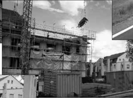
Entfernung des Daches, Achse 1-5
